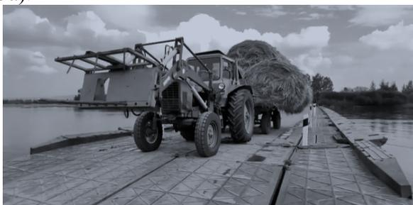
а) полимерный понтонный мост с металлизированным покрытием
